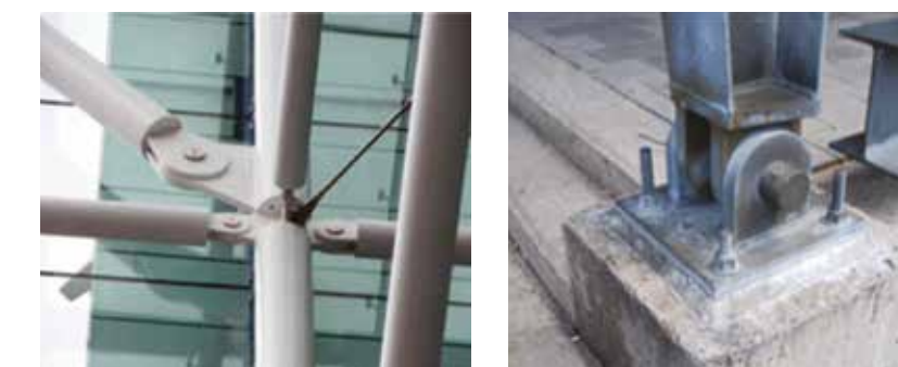
Figur 2-4: Exempel på ledad anslutning i pelartopp.
