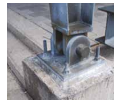
Figur 2-5: Exempel på ledad anslutning vid pelarfot.
