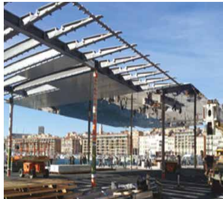
Figur 2-21: Referensprojekt för att exemplifiera utkragande avsmalnande balkar.
